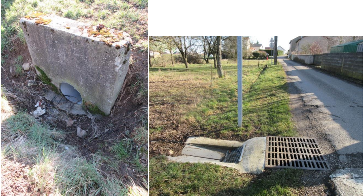
Fig. 4. BV n°1 - entrée de la canalisation d'assainissement (à gauche) et du réseau d'eau pluviale (à droite)
