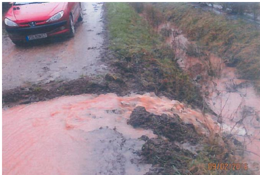
Fig. 9. BV n°2 - Merlon de terre redirigeant les eaux en provenance du bassin versant numéro 2 (source : mairie)
