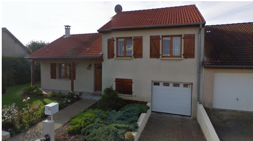
Fig. 10. BV n°2 – Habitation touchée (garage) au n°26 rue du Grand Pré
