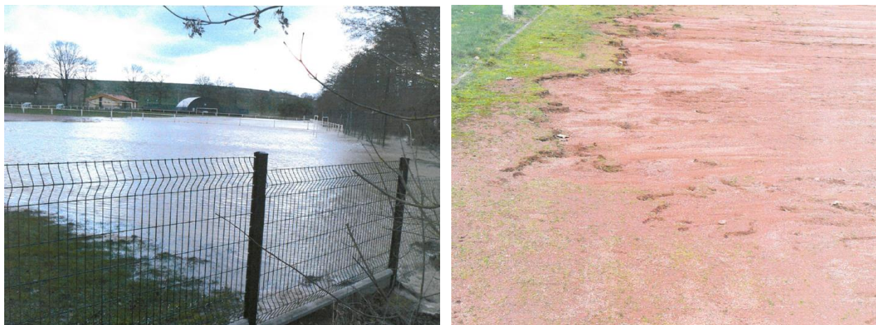
Fig. 12. BV n°2 – Inondation des terrains de football par débordement du ruisseau et dégâts occasionnés (source : Mairie)
