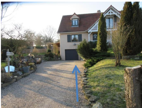
Fig. 4. BV n°1a – Photographie du garage inondé en 2016
