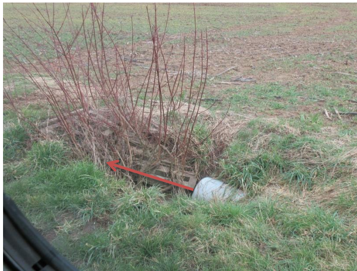
Fig. 5. BV n°1 – exutoire du tronçon canalisé du fossé
