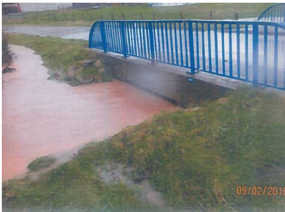
Fig. 10. Pont franchissant le ruisseau de la Gueule en charge en 2016 (source : mairie)
