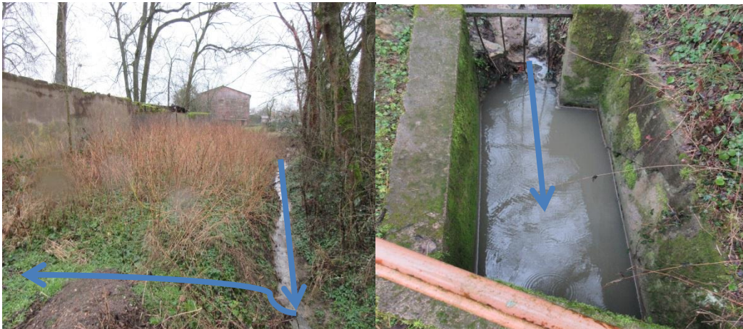
Fig. 9. BV n°2 - Sens d'écoulement de l'eau sur le bassin versant numéro 2
