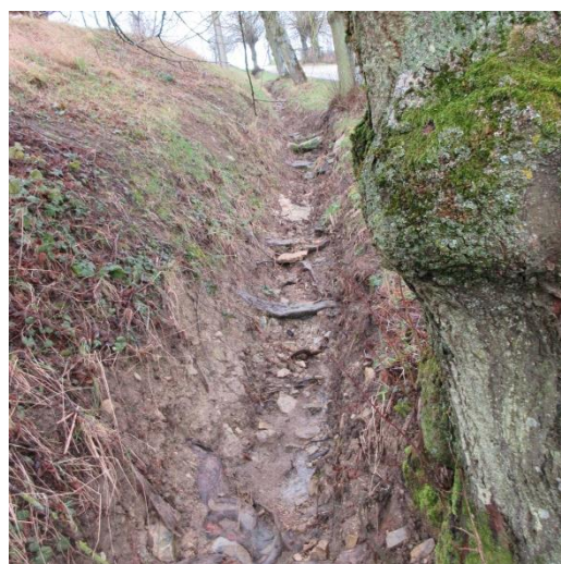
Fig. 4. BV n°1 – La RD71 et l'érosion du fossé en amont du village
