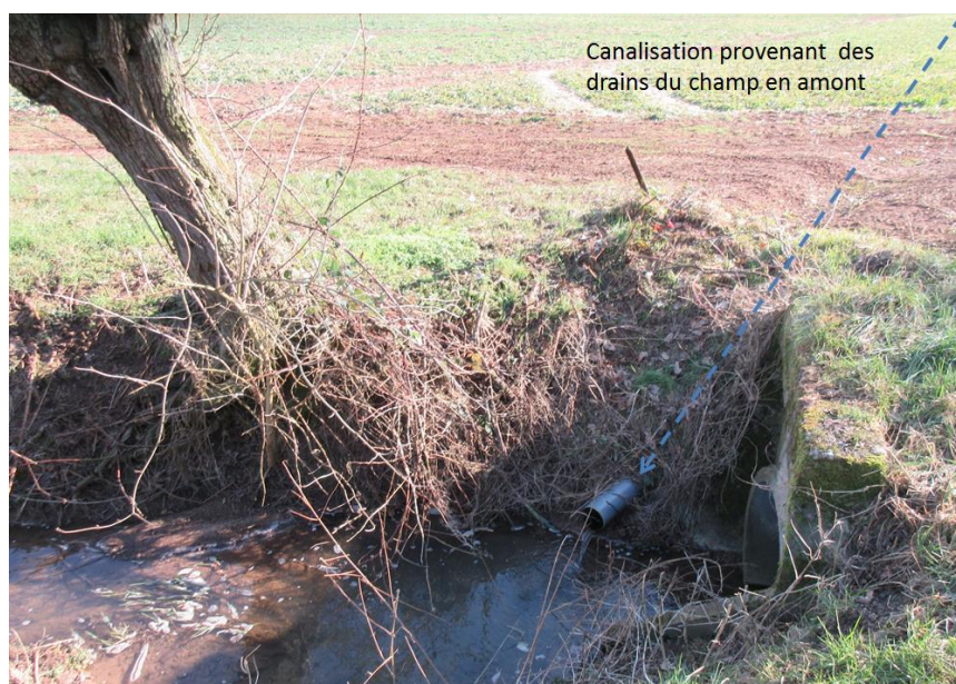
Fig. 7. BV n°2 - sortie du drainage dans le ruisseau de la gueule
