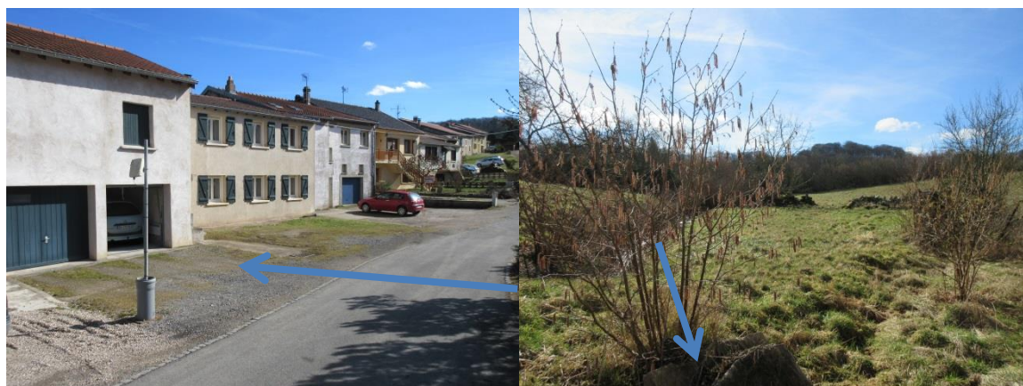
Fig. 9. BV n°2 – photographies de l'habitation touchée en 2016 et vu versant amont
