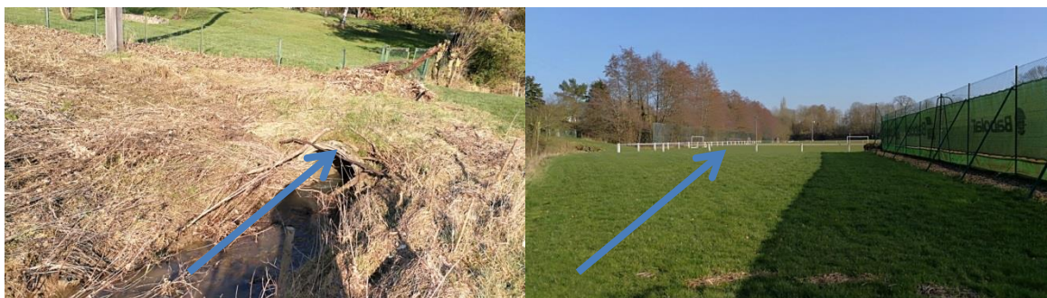
Fig. 11. BV n°2 - Sens d'écoulement de l'eau sur le bassin versant numéro 2 et terrain de foot touché par les débordements du ruisseau
