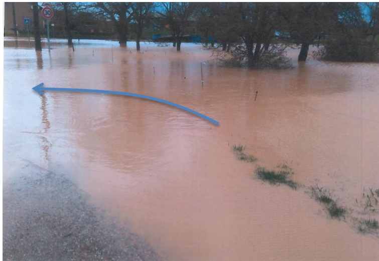
Fig. 5. BV n°1 - Surverse des ruissellements sur la route
