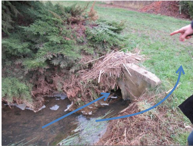
Fig. 4. BV n°1 – Point de débordement amont
