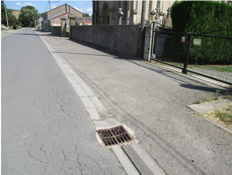
Fig. 4. Fin du tronçon avec bordure de trottoir
