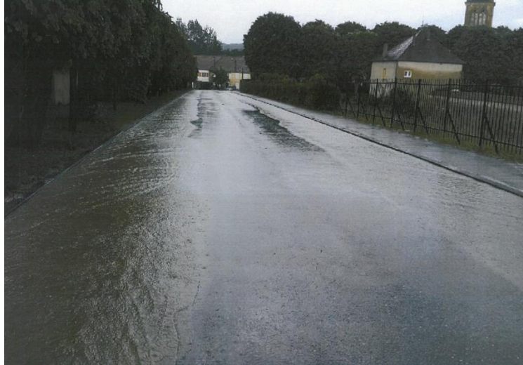
Fig. 6. BV n°1 – Propagation des eaux sur l'Allée des Tilleuls (source : Mairie)
