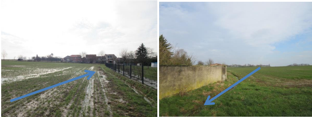
Fig. 8. BV n°2 - Sens d'écoulement de l'eau
