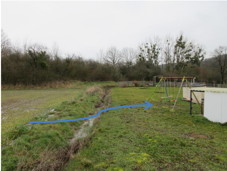
Fig. 4. BV n°1 - Débordement de l'afflux d'eau en direction de la maison
