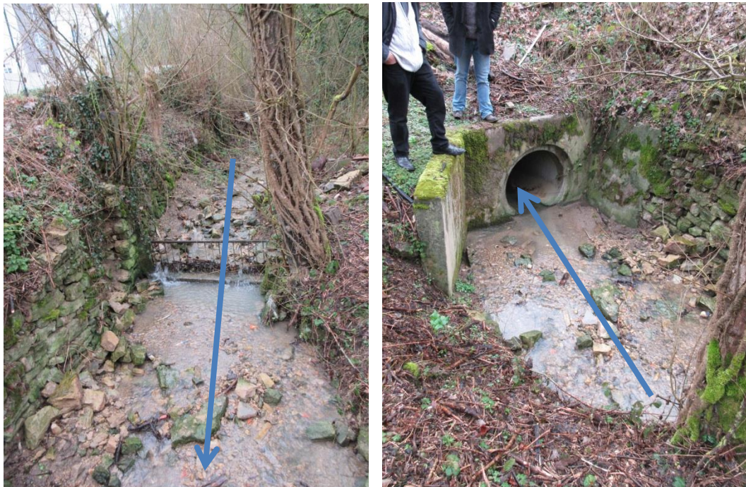
Fig. 6. BV n°1 – Photographie du ruisseau et de l'entrée de la section canalisée au droit de la rue de Charme
