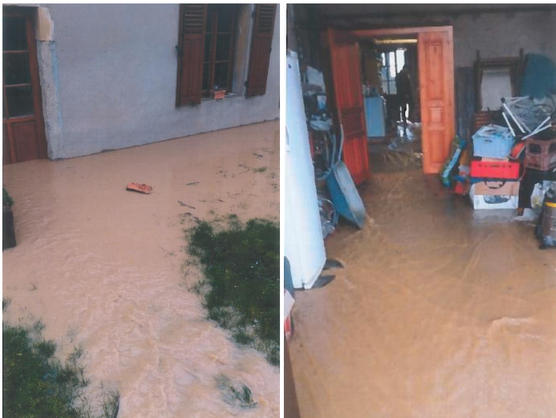
Fig. 6. BV n°1 - Inondations des habitations n°4 de la rue Principale (à gauche) et n°10 de la rue Principale (à droite)
