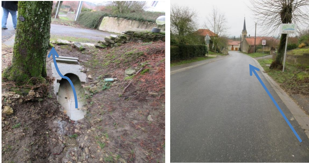
Fig. 5. BV n°1 - Sens d'écoulement de l'eau sur le bassin versant numéro 1 au niveau de la RD 71 (entrée de la buse se colmatant et écoulements sur la route en aval)
