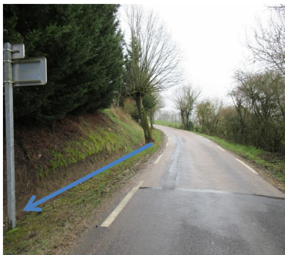
Fig. 4. BV n°1 – La RD71 et l'érosion du fossé en amont du village
