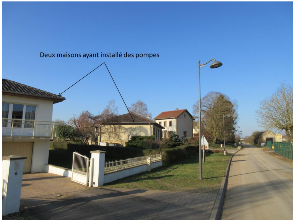
Fig. 6. BV n°1b – Maisons concernées par des refoulements du réseau en 2016
