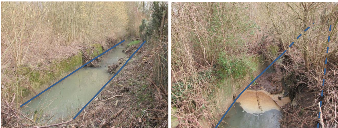
Fig. 4. Photographie du tronçon aval dégagé (à gauche) et encombré (à droite) avec délimitation du lit mineur
