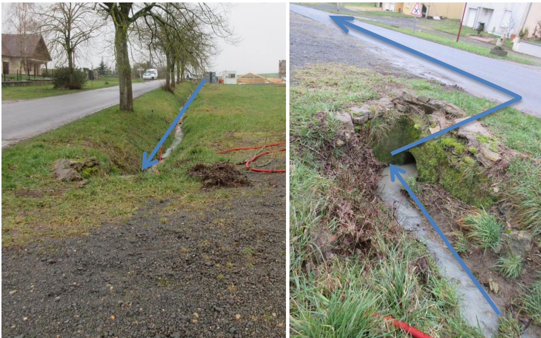
Fig. 3. BV n°1 - Sens d'écoulement de l'eau et entrée de la canalisation
